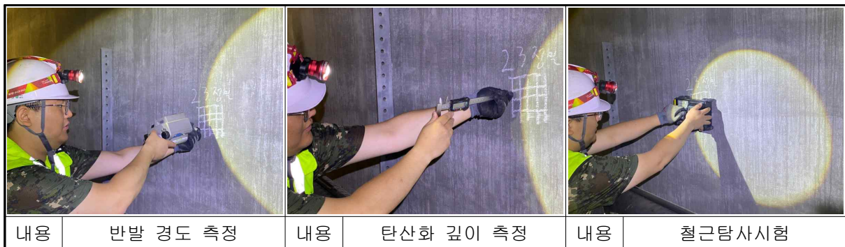
【사진 10.4】 신평주분기 전력구 재료시험 전경
